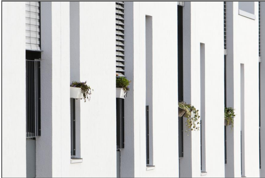
Afd. 35 Lærkehaven sydfacade
