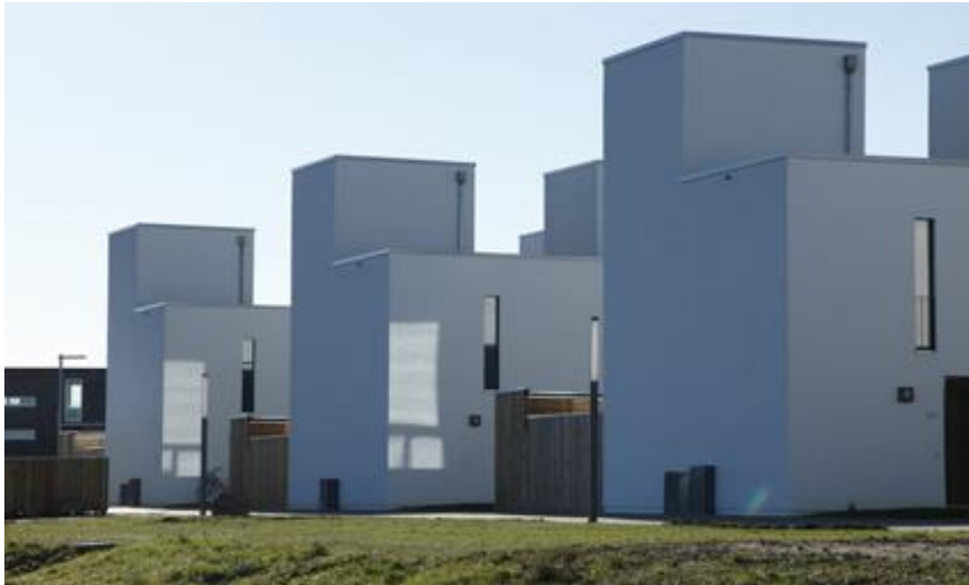
Afd. 35 Lærkehaven set fra nord, som er indgangssiden.
